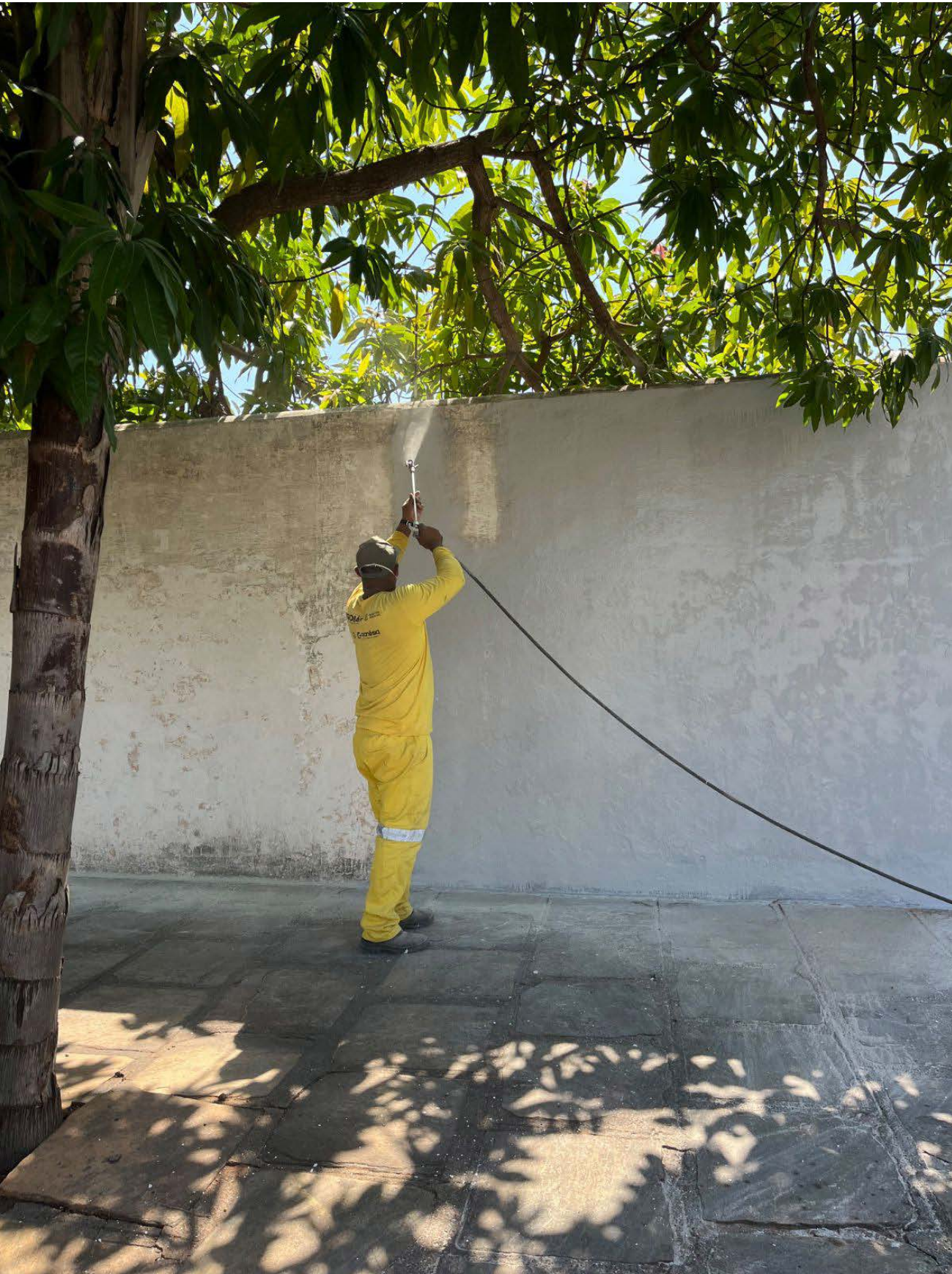
Serviço de pintura do muro do Cemitério Municipal, ontem
